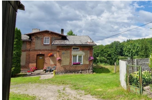
Zabudowa zagrodowa przy ul. Nowe Osiedle
