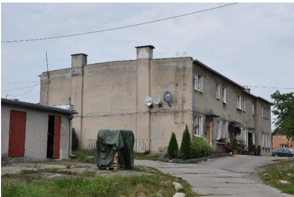
Budynek z lokalami komunalnymi przy ul. Sambora
