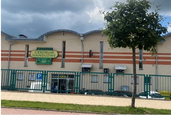
Centrum Handlowe Kaszebe przy ul. Dworcowej
