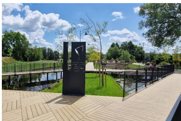
Przestrzeń publiczna nad Klasztorną Strugą
