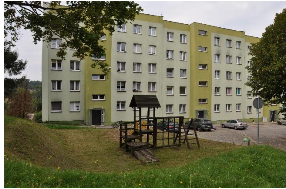
Blok wielorodzinny na Osiedlu XX-lecia
