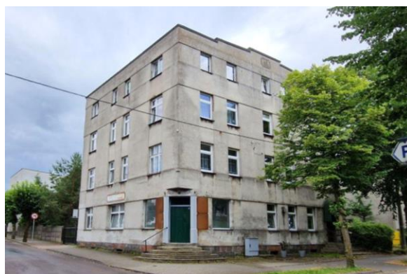
Modernistyczna kamienica przy ul. Majkowskiego
