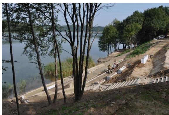
Kąpielisko miejskie (w budowie)
