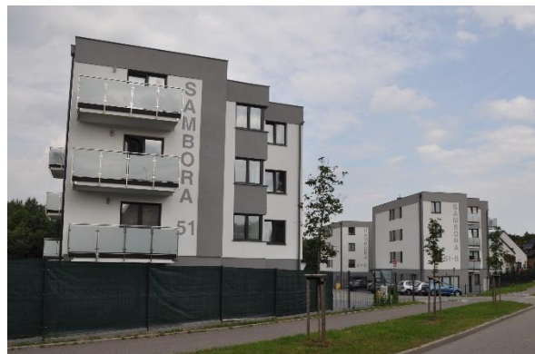
Nowa zabudowa przy ul. Sambora
